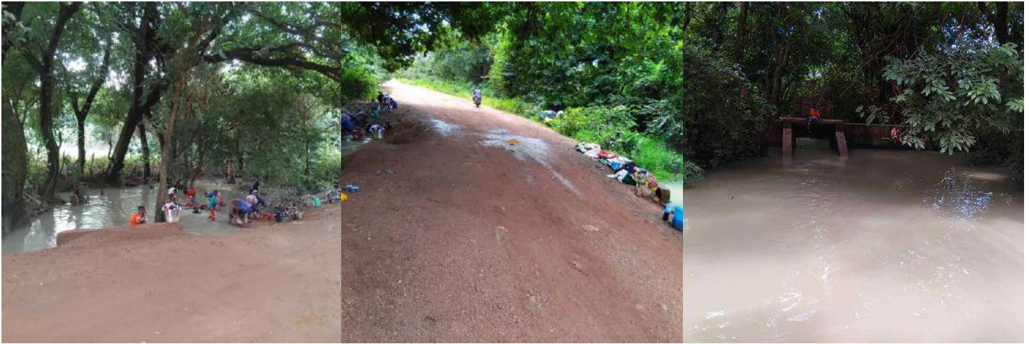
Photographie 9 : Cours d'eau Fandjia à Damissakoura (absence de pont et vanne de fermeture du cours d'eau)
