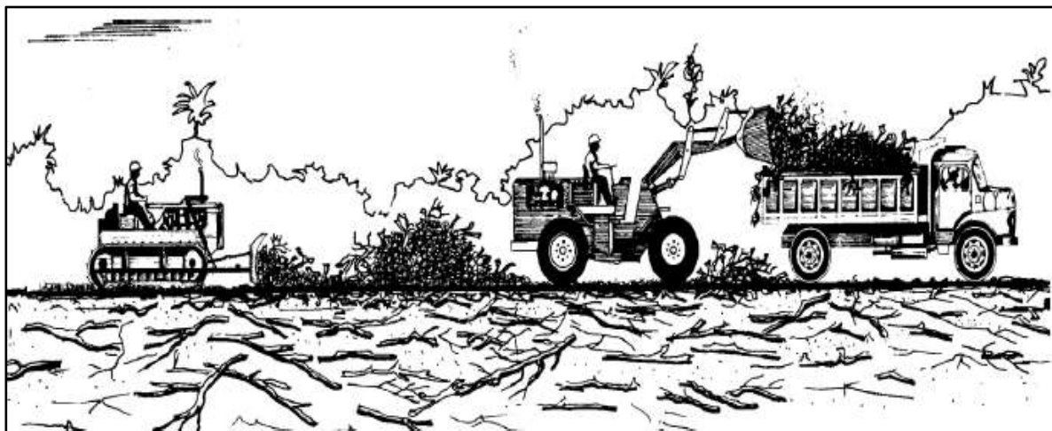
Figure 6 : travaux de débroussaillage
