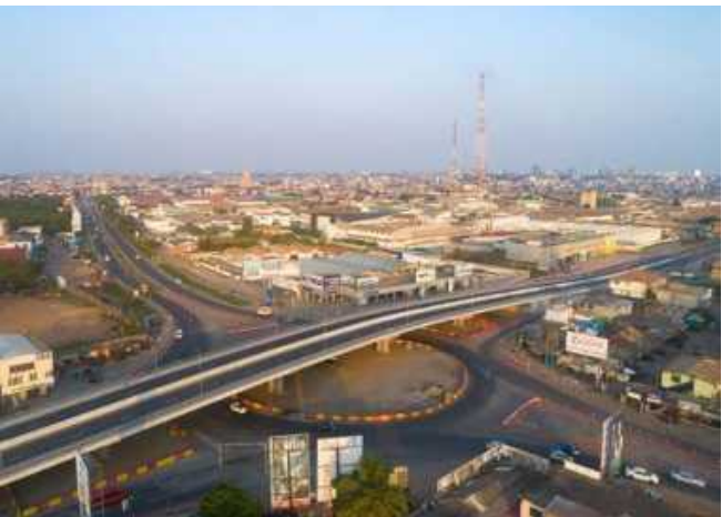
Projeto em construção Fase 2: Construção de um viaduto de norte para sul; melhoria da atual rotunda de Obetsebi Lamptey ao nível do solo; e realização de obras de drenagem contíguas.
